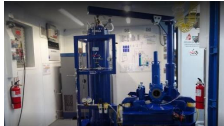
Calibración de valvulas de seguridad en banco
